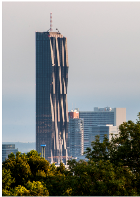
© Gmeiner Haferl Zivilingenieure ZT GmbH
