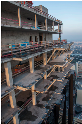
© Gmeiner Haferl Zivilingenieure ZT GmbH
