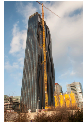
© Gmeiner Haferl Zivilingenieure ZT GmbH
