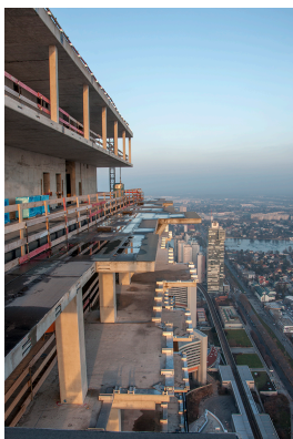
© Gmeiner Haferl Zivilingenieure ZT GmbH
