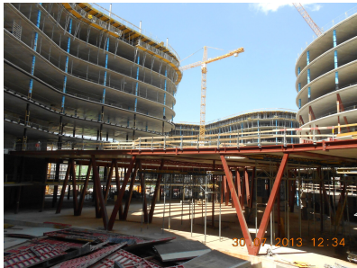
© Gmeiner Haferl Zivilingenieure ZT GmbH
