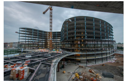
© Gmeiner Haferl Zivilingenieure ZT GmbH
