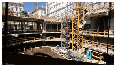
© gmeiner haferl zivilingenieure zt gmbh
