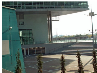
© Gmeiner Haferl Zivilingenieure ZT GmbH
