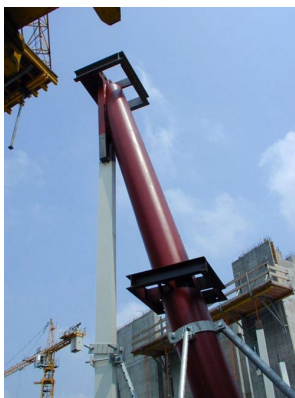
© Gmeiner Haferl Zivilingenieure ZT GmbH
