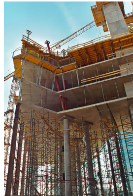
© Gmeiner Haferl Zivilingenieure ZT GmbH
