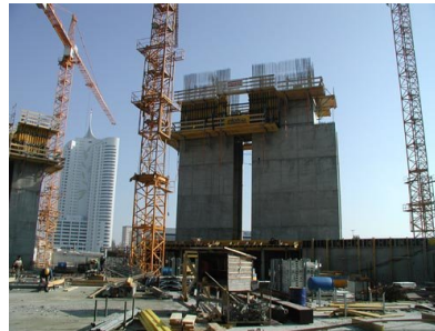
© Gmeiner Haferl Zivilingenieure ZT GmbH
