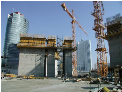
© Gmeiner Haferl Zivilingenieure ZT GmbH
