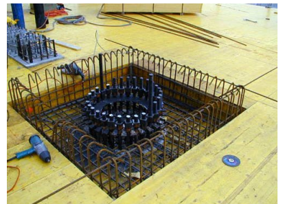
© Gmeiner Haferl Zivilingenieure ZT GmbH
