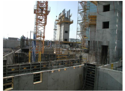
© Gmeiner Haferl Zivilingenieure ZT GmbH
