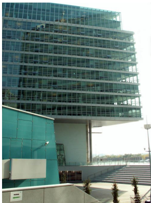
© Gmeiner Haferl Zivilingenieure ZT GmbH
