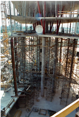
© Gmeiner Haferl Zivilingenieure ZT GmbH
