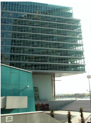
© Gmeiner Haferl Zivilingenieure ZT GmbH
