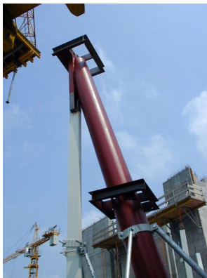
© Gmeiner Haferl Zivilingenieure ZT GmbH
