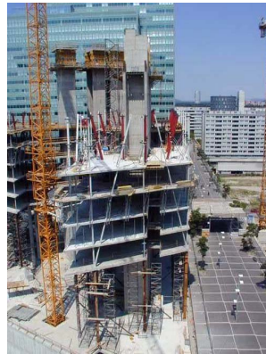
© Gmeiner Haferl Zivilingenieure ZT GmbH
