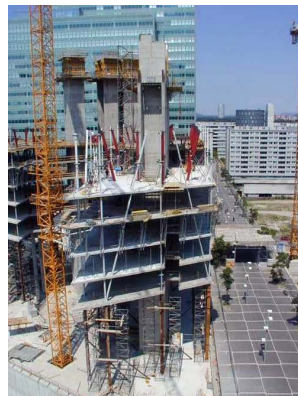
© Gmeiner Haferl Zivilingenieure ZT GmbH
