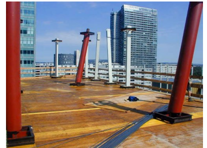
© Gmeiner Haferl Zivilingenieure ZT GmbH
