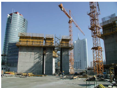
© Gmeiner Haferl Zivilingenieure ZT GmbH
