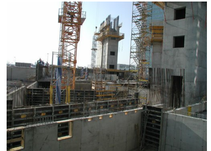
© Gmeiner Haferl Zivilingenieure ZT GmbH
