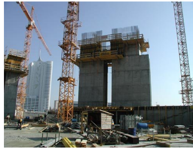
© Gmeiner Haferl Zivilingenieure ZT GmbH
