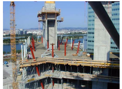
© Gmeiner Haferl Zivilingenieure ZT GmbH
