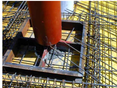
© Gmeiner Haferl Zivilingenieure ZT GmbH
