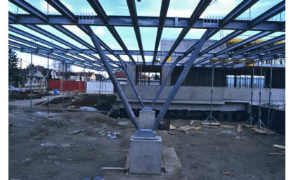
© Gmeiner Haferl Zivilingenieure ZT GmbH
