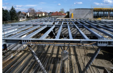
© Gmeiner Haferl Zivilingenieure ZT GmbH
