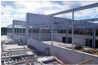
© Gmeiner Haferl Zivilingenieure ZT GmbH
