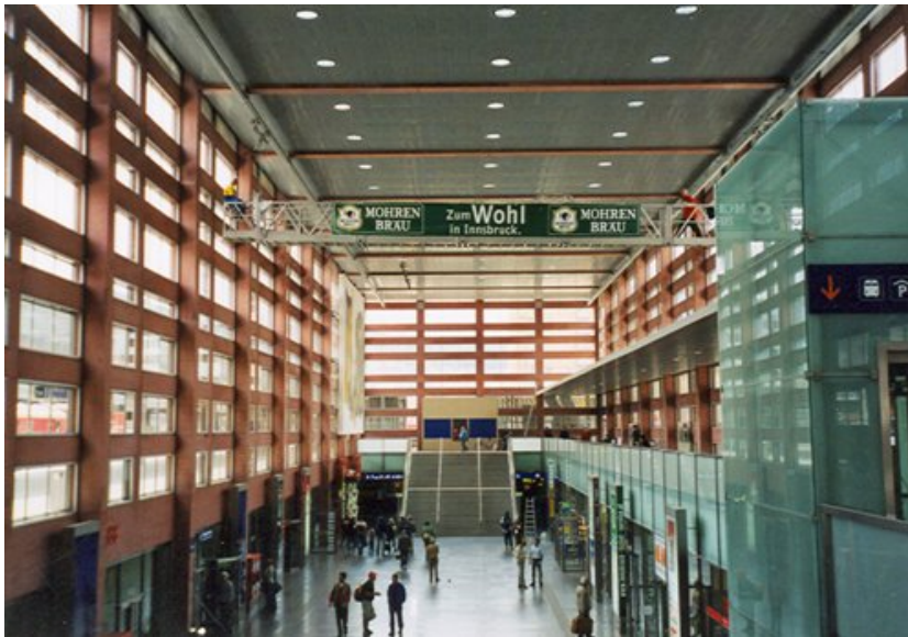
© Gmeiner Haferl Zivilingenieure ZT GmbH
